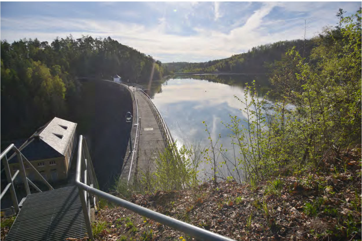
Abb 2: Blick von Westen auf das Staubbauwerk der Talsperre Weida. Foto: FBE 2019
